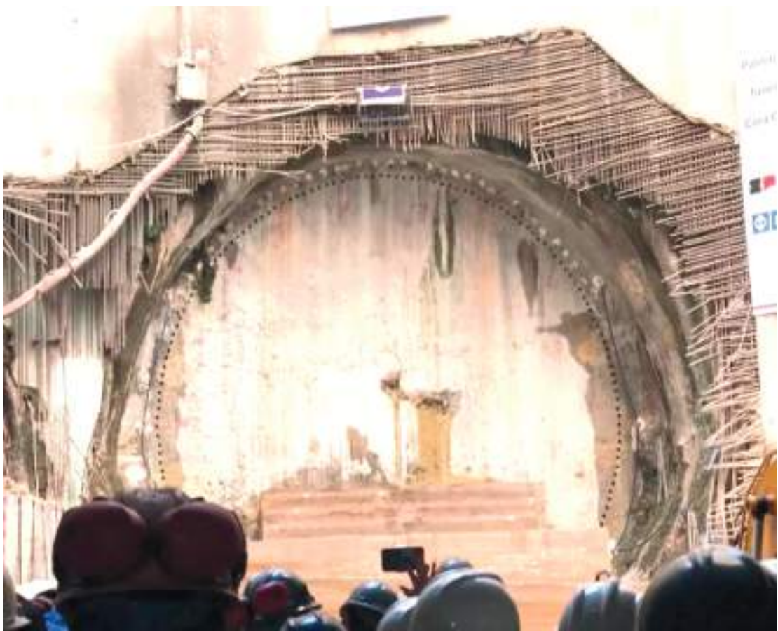
O tatuzão já cavou 4,5 km de extensão, sendo 3,7km de túneis construídos
