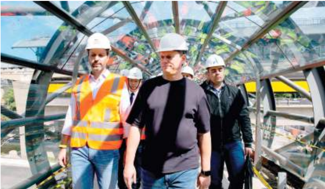
Tarcísio visitou as obras que deveriam ter sido entregues para a Copa do Mundo de 2014
