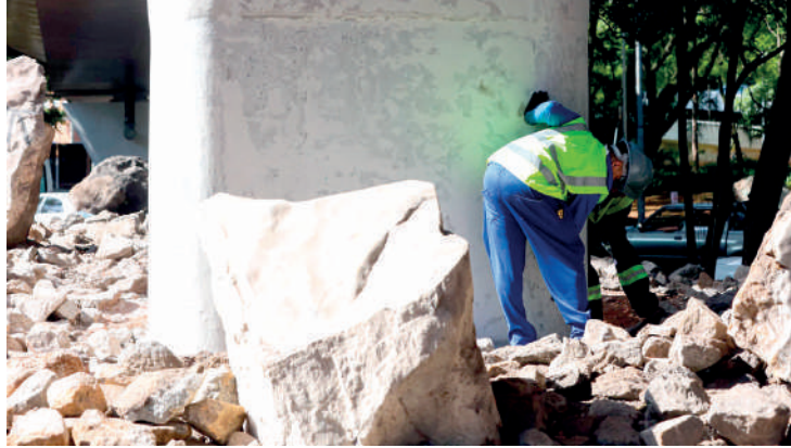
Intervenções são parte do Programa de Recuperação de Pontes e Viadutos
