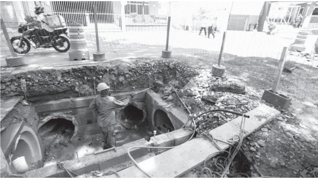
Trabalhos executados pela Prefeitura nas galeiras trarão mais segurança à quem mora próximo
