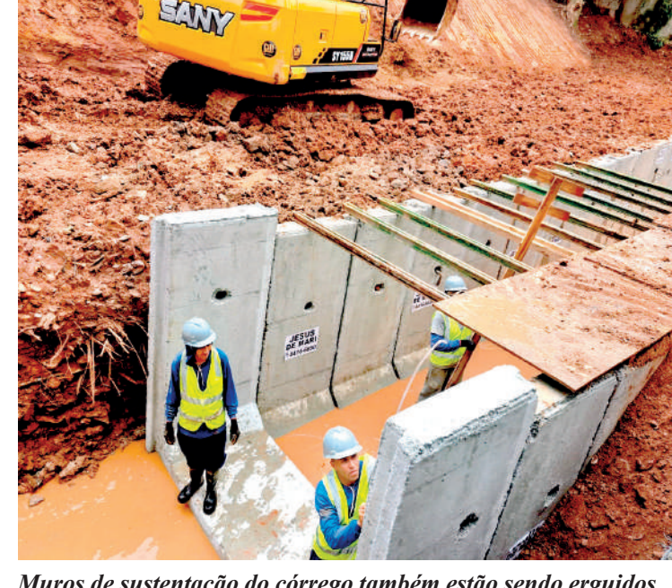
Muros de sustentação do córrego também estão sendo erguidos
