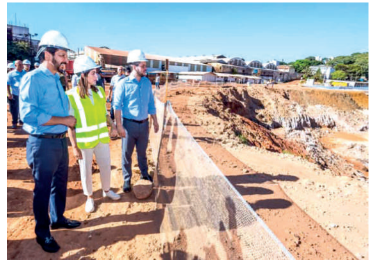
Reservatório terá capacidade para armazenar 900 mil m 3
